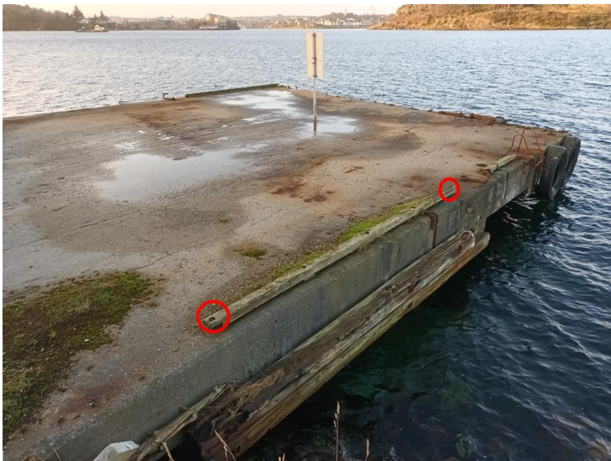
Figur 6. CCA-impregnert trevirke på Roaldsøy kai. Prøvepunkt er markert med rødt omriss.
