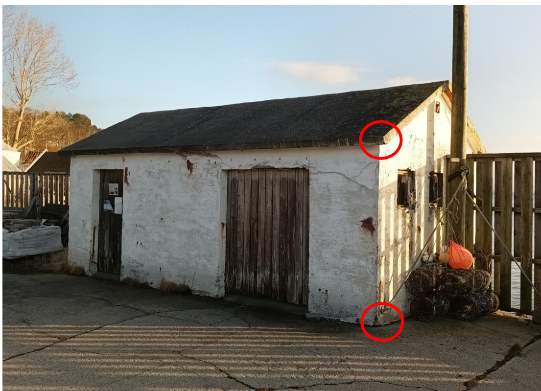
Figur 7. Venteskuret på Roaldsøy. Prøvepunkter for betongvegg og betongtak er vist med rødt omriss.
