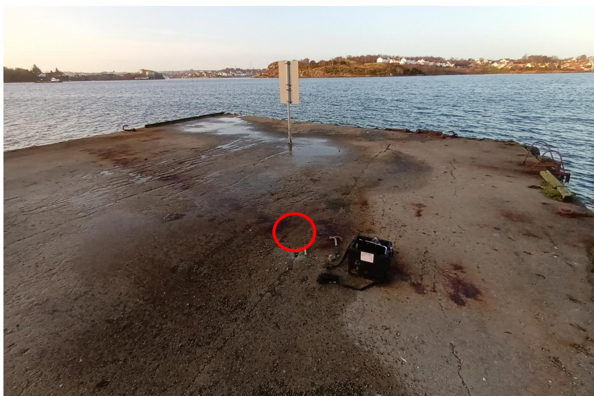
Figur 3. Kaidekket ved Roaldsøy kai. Prøvepunktet er markert med rødt omriss.
