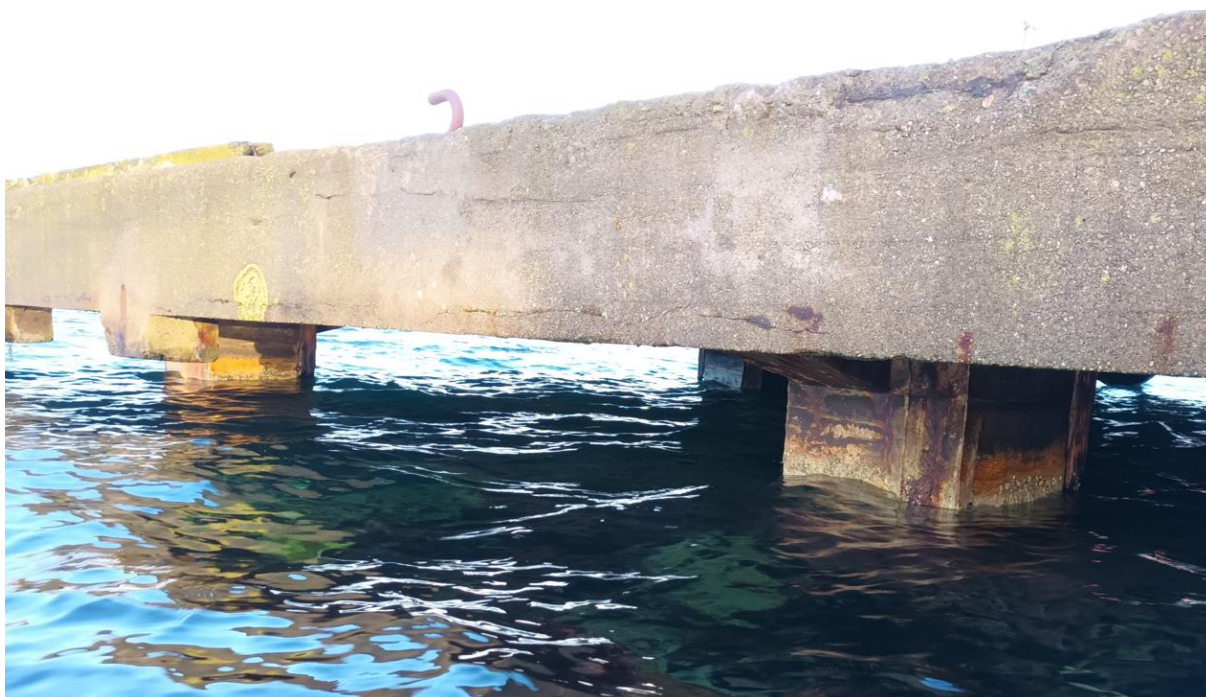
Figur 5. Betongpilarer ved Roaldsøy kai.
